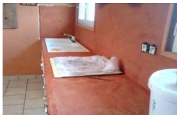
Application de deux couches de sp1 et d'une couche se sp2
